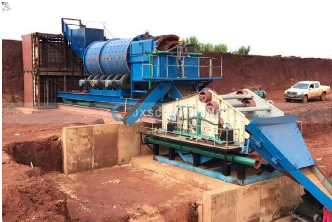
Figura 52: Planta de tratamento do Cascalho
